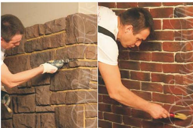
12. После того, как раствор немного затвердеет, **разгладьте его** с помощью шпателя или фигурной лопатки для расшивки. Для окончательного выравнивания и шлифовки швов необходимо обмести их щеткой средней жесткости.
