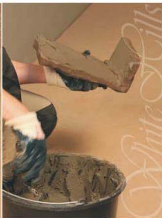
**7. Монтаж камня** начинайте с угловых элементов. Нанесите клеевой раствор на тыльную поверхность камня, чтобы вся его площадь была равномерно покрыта клеем.
