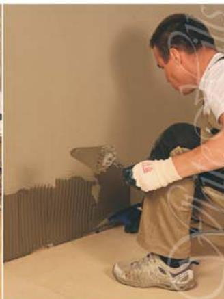
**6. Нанесите гладким шпателем** клеевой раствор на подготовленную стену. Разровняйте клей зубчатым шпателем.
