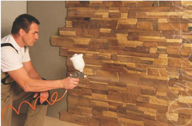
13. После окончательного высыхания кладки, можно обработать ее специальным защитным гидрофобным составом с помощью распылителя или кисти. Перед применением гидрофобизатора внимательно ознакомьтесь с инструкцией по его использованию.
