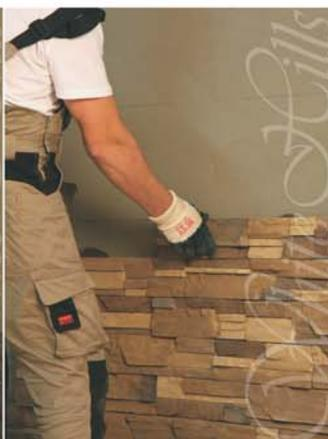
**8. Крепко прижмите камень** к стене и слегка «подвигайте» из стороны в сторону, чтобы обеспечить наилучшее сцепление. Для монтажа камня с расшивкой используйте чопики для фиксации камня.
