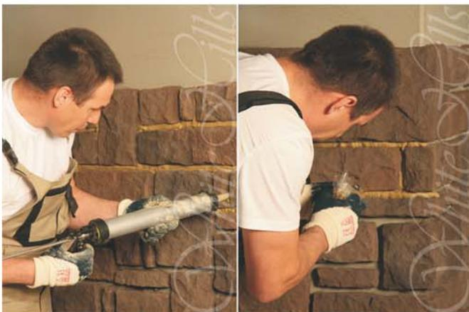
11. Заполните швы с помощью строительного шприца-пистолета или специального кулика для затирки, медленно выдавливая затирочный раствор.
